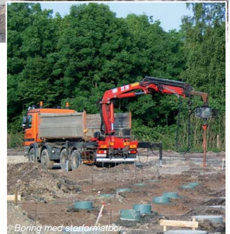
Boring med storformatbør
